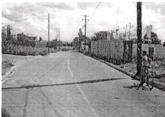
VISTA NORTE A SUR
