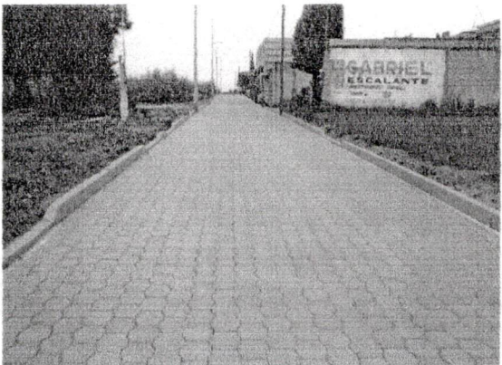
VISTA DE NORTE A SUR
