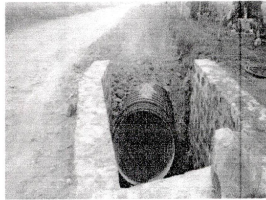
VISTA DE DESCARGA
